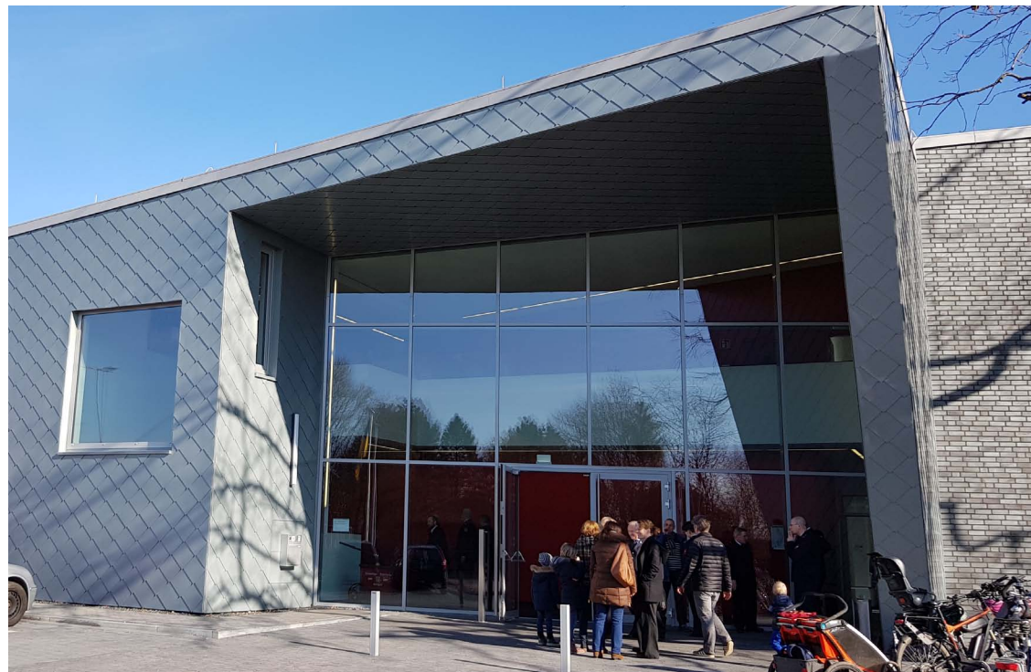
Das neue Feuerwehrhaus vom Löschzug Büttgen
