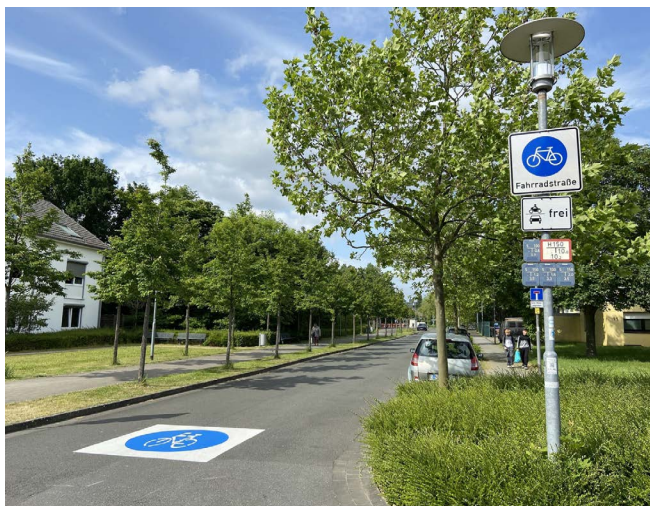
Die neue Fahrradstraße „Am Pfarrzentrum“ in Holzbüttgen.
